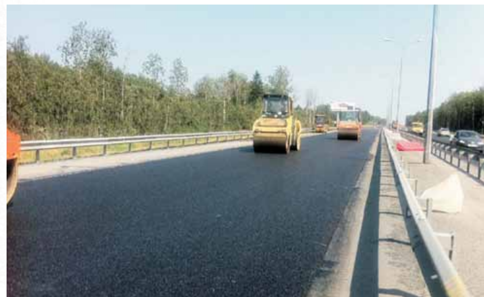
Устранение колеиности на КАД СПб с применением ЩМА-20 (порфирит), июль 2011 года
