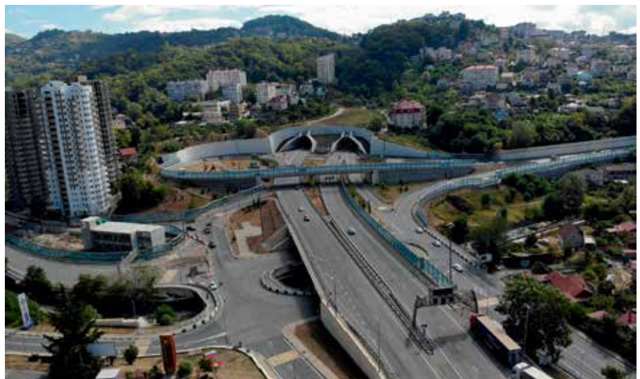
Дублер Курортного проспекта. III очередь строительства, тоннели №8 и №8а (г. Сочи)
