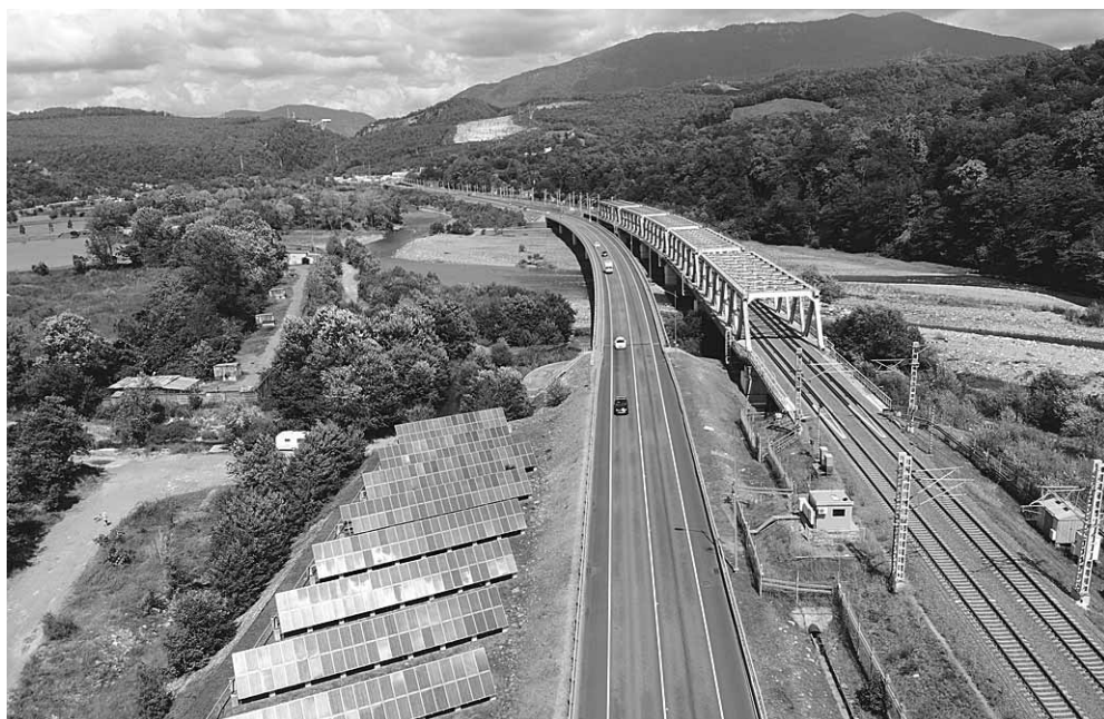
Совмещенная (автомобильная и железная) дорога Адлер – горноклиматический курорт «Альпика-Сервис»
