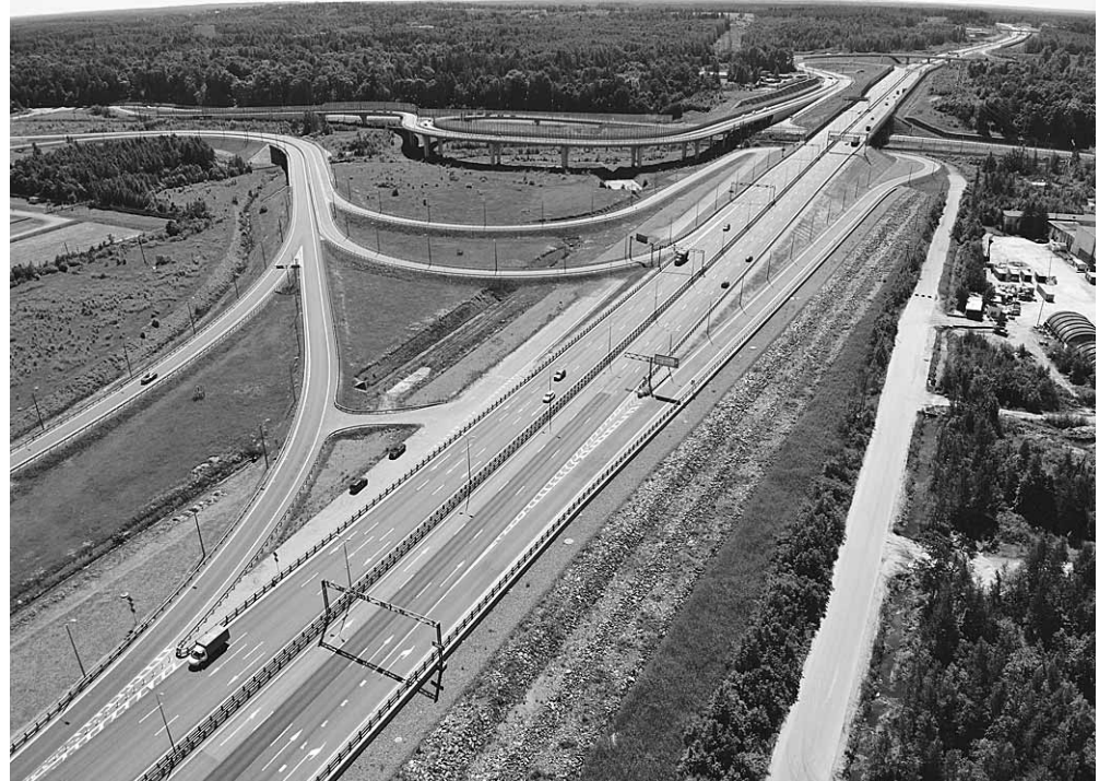
Кольцевая автомобильная дорога вокруг Санкт-Петербурга в р-не ст. Бронка
