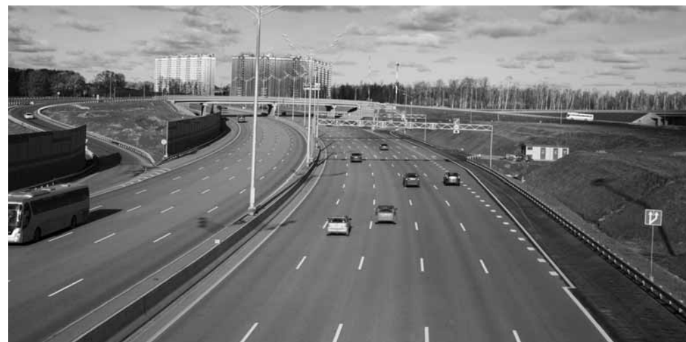
Скоростная платная автомобильная дорога М-11 «Нева» на участке км15 – км58
