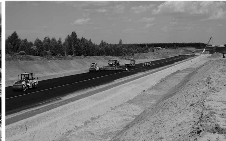
Строительство скоростной автомобильной дороги М-12 в Нижегородской области
